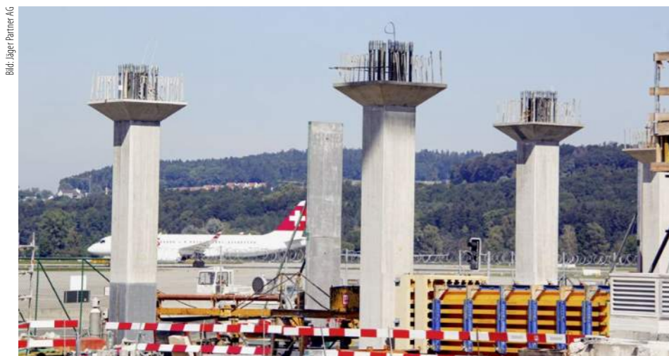
Die bewehrten und gegossenen Betonpfeiler warten aufs nächste Stockwerk: In unmittelbarer Nähe des Rollfeldes wächst der Neubau für die Gepäcksortieranlage des Flughafens Zürich in die Höhe.
